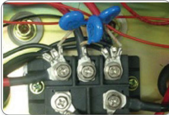
Figura15 - Cabo de saída da ponte desconectado.
