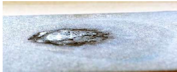
Ponto de solda removido
